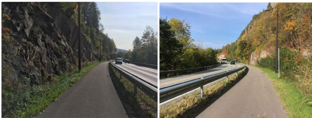
Figur 11. Bilde ved planlagt kryssing av E134. Retning sør (venstre bilde). Retning nord (høyre bilde).
