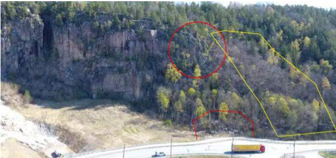
Figur 13. Område vest for påhugsområde, her markert med rødt og gult bør utredes nærmere med en detaljert faresonekartlegging. Avlåste blogger i fjellskråning er observert.
