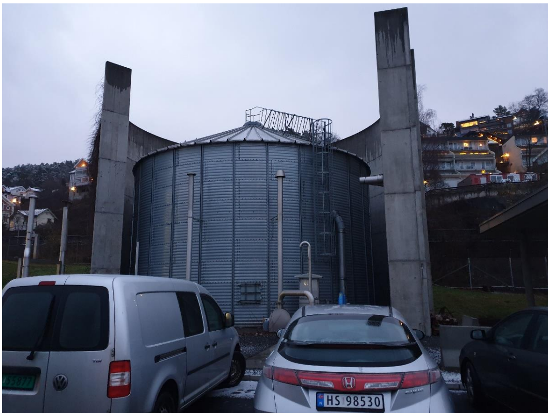
Figur 7. Gasstank ved Bekkelaget renseanlegg.
