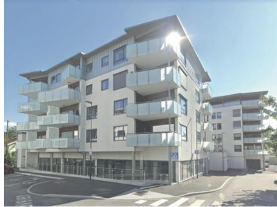
Boliger ved Fosskvartalet i puss, platekledning og balkonger med fronter i frostet glass
