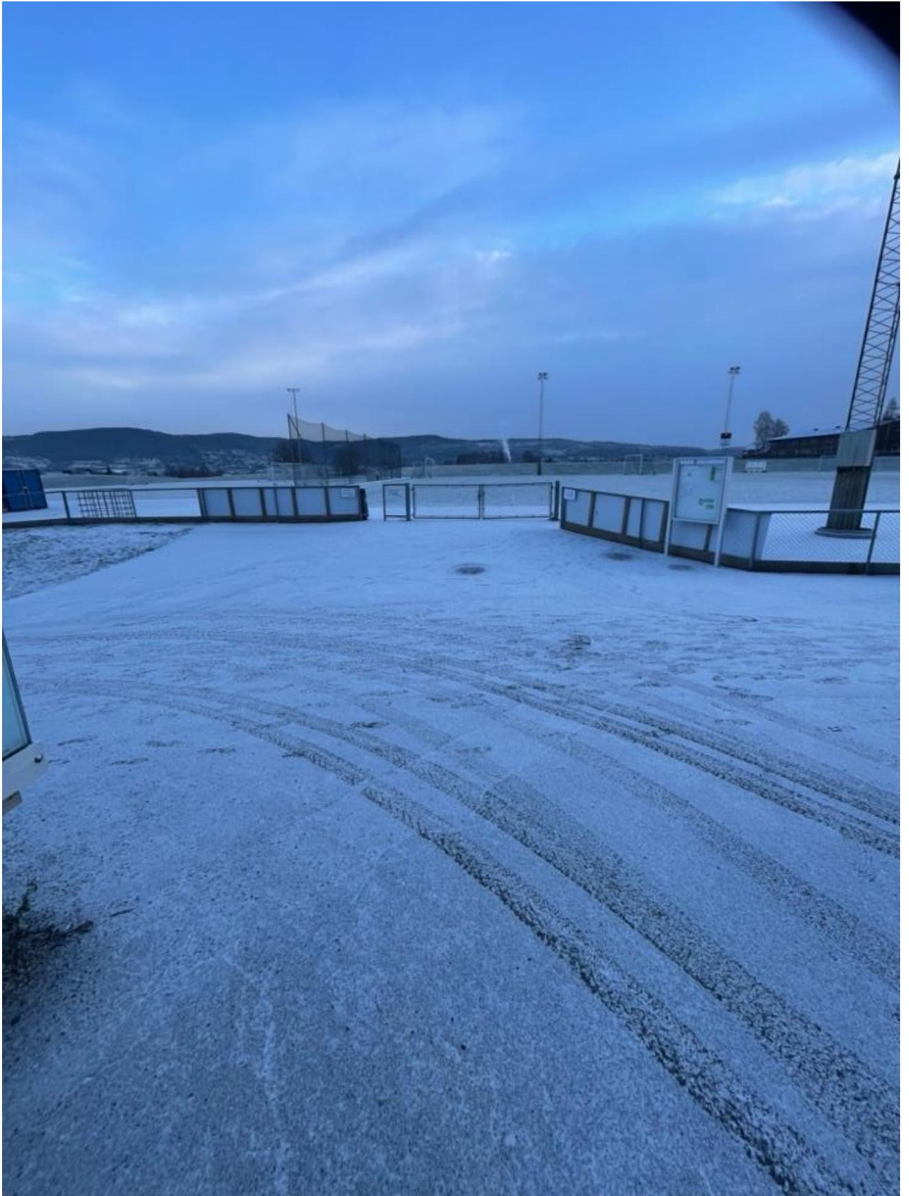
Vedlegg 8 - Gjerdet nord for snø-deponiet
