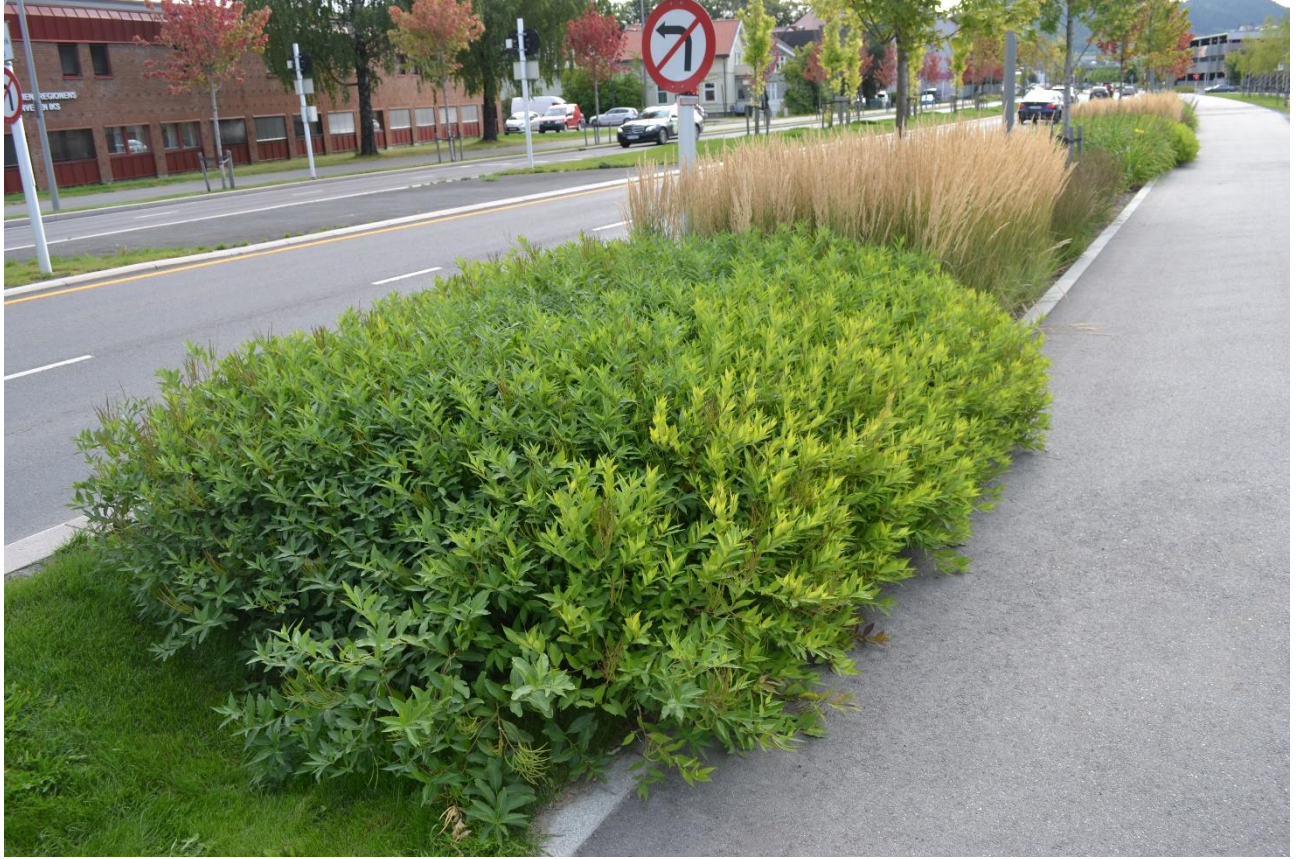
Figur 10. Regnbedet i Bjørnstjerne Bjørnsons gate har inngått i et FoU-prosjekt for å undersøke jordoppbygning og overlevelse av ulike stauder i regnbed (Foto: Trond Knapp Haraldsen)
