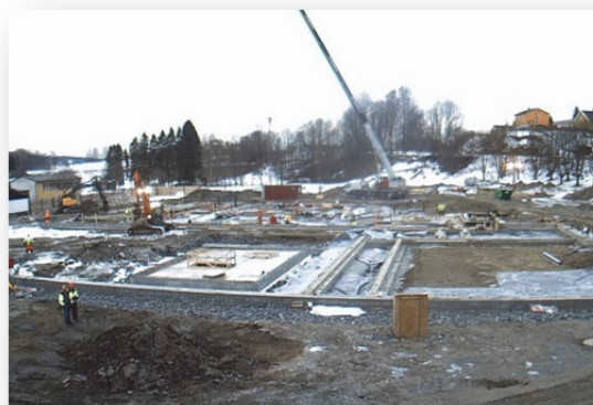
Ny Hegg skole under arbeid
